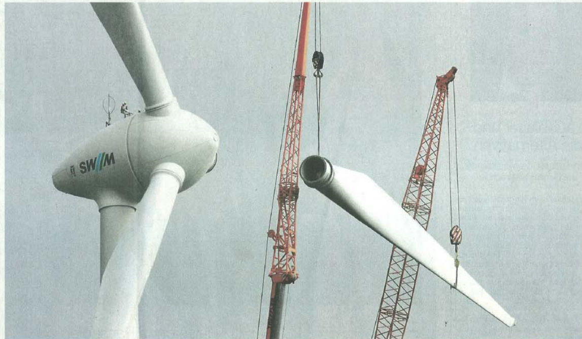
Auf dem Fröttmaninger Berg steht bereits eine Windkraftanlage der Münchner Stadtwerke. Unser Bild zeigt den Austausch der Rotorblätter an dem Windrad, das von Gegnern als Landschaftsveränderung empfunden wird. Foto: Robert Haas
